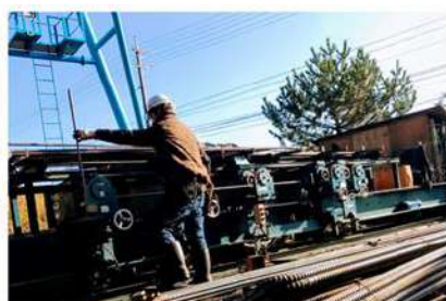
鉄筋の加工
